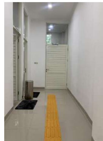
Guiding Block menuju toilet
