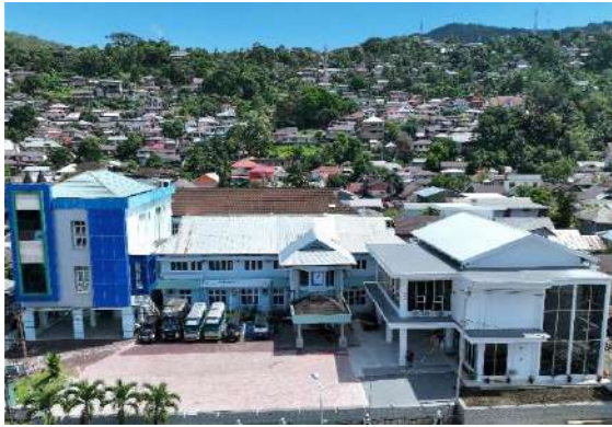
Gambar 7. Gedung Balai POM di Ambon
